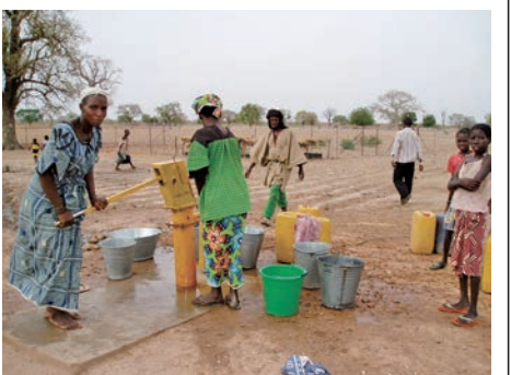
手押しポンプ付の深掘井戸
