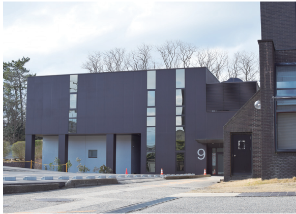
竣工した生物科学施設（9号館）2階にSPF（特定の病原体を含まないことを保証された動物）のラットとマウスの飼育施設を新設
