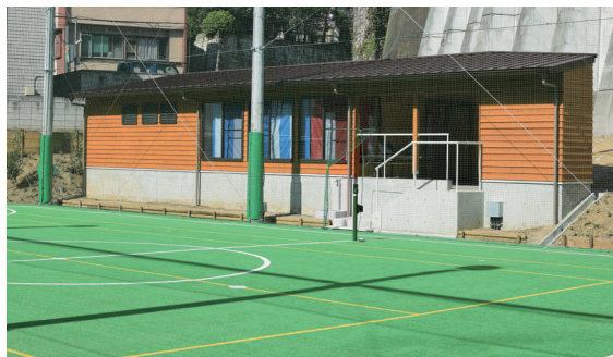
完成したクラブハウスとフィールド
