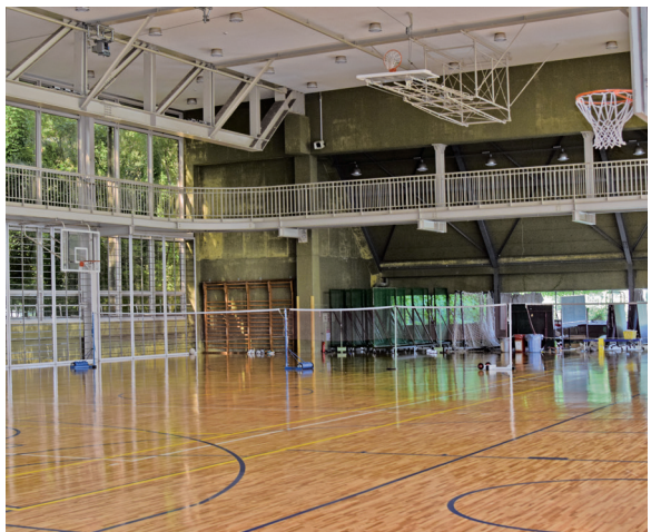
フローリングに改修なった体育館2階
